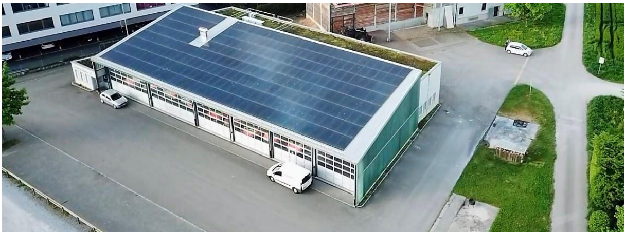
Fotovoltaikanlage auf Feuerwehrgebäude
